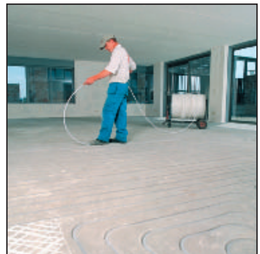
Die Heizrohre werden mit geschickter "Fußarbeit" in den Rillen verlegt.
