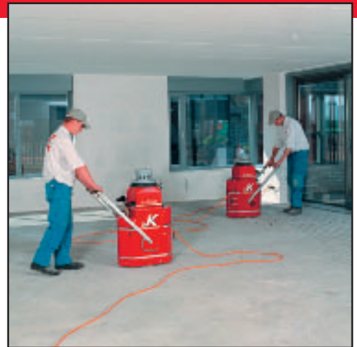
Einfräsen! Mithilfe der patentierten Fräsmaschine wird ein exaktes Rillennmuster eingebracht.
